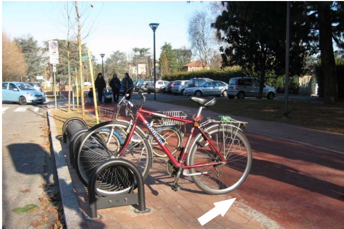
1. Portabici che fa invadere la pista alle bici parcheggiate
